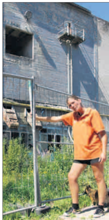
Eindringlinge haben den Zaun auf Höhe des Potenbergwerks aufgestemmt. Dabei haben sie die schweren Sicherheitsschellen mit brachialer Gewalt aufgebrochen.
